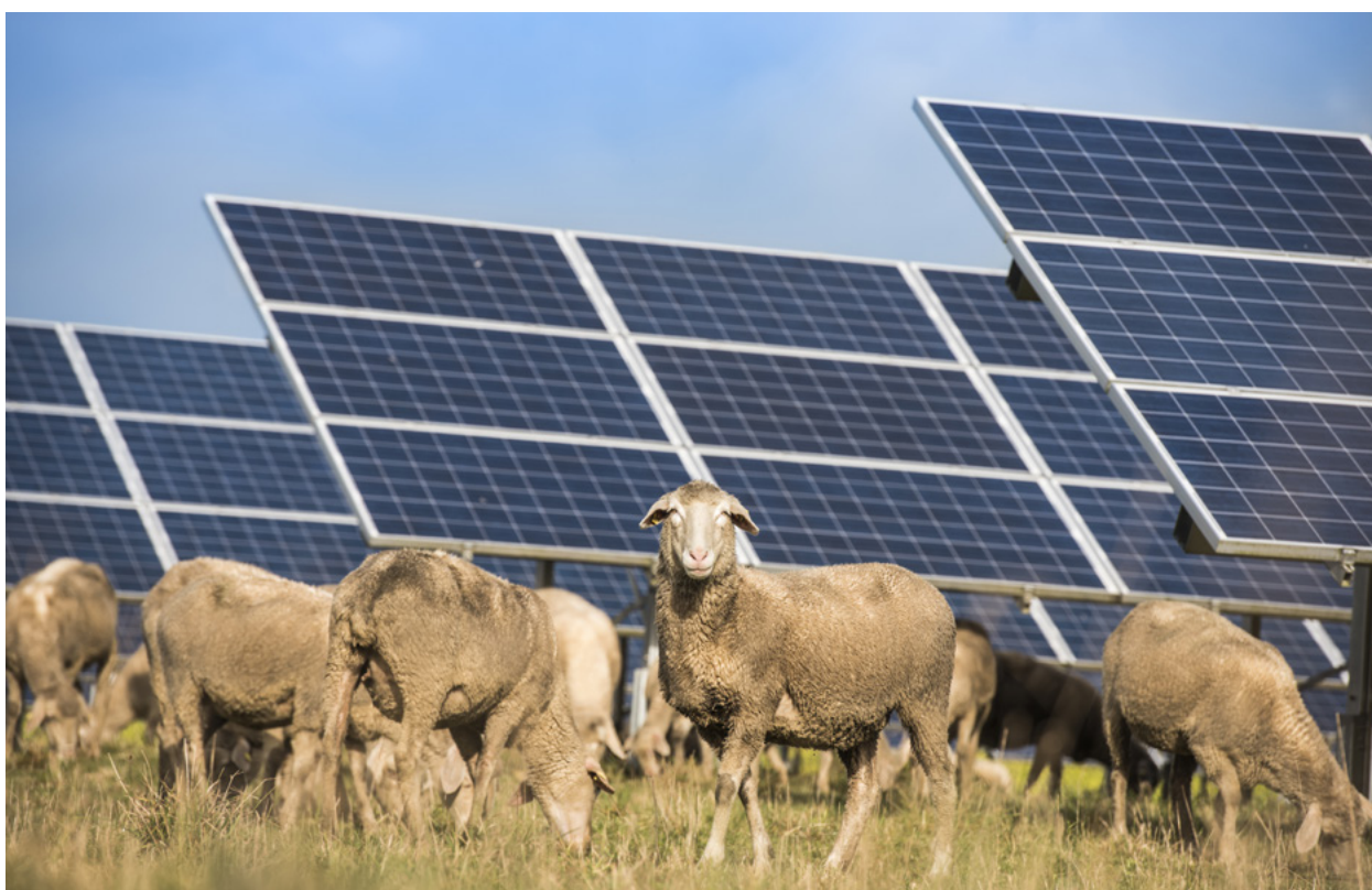
Slika 7. Solarni paneli u stočarstvu
