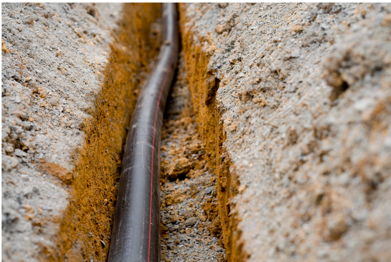
Slika 6. Ukopavanje cijevi za subirigaciju
